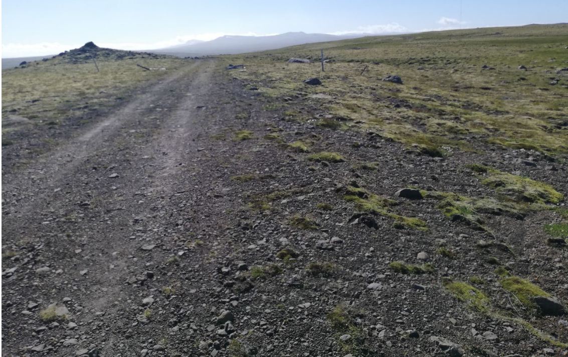
Mynd 42. Jökulruðningur á yfirborði við núverandi slóða, mögulega nothæft efni í vegfyllingar (A:389955 N:528461).
